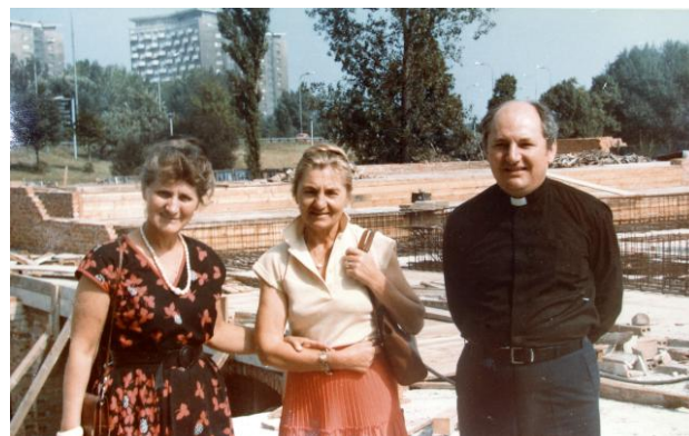
Ksiądz Ryszard Marciniak, Zofia Cybik (z Australii) i Maria Gabiniewicz – ciocia Marynia na tle budowy położonego stropu nad Dolnym Kościołem.
